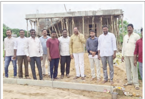
సీసీ రోడ్డు పనులను ప్రారంభించిన సర్పంచ్ వెంకటేశ్
